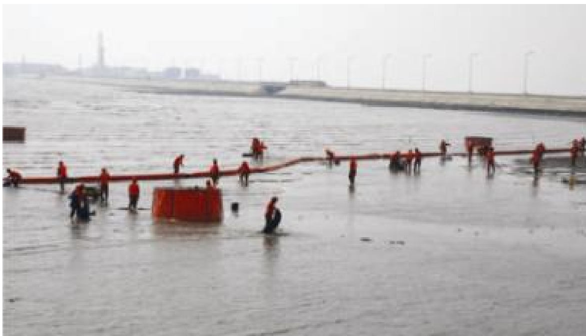
图 13 岸滩围油栏的布放方式二
